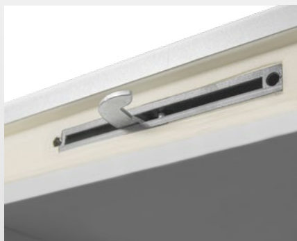
Zámkové spojování panelů
